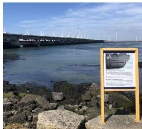
Le barrage « deltaworks project ».
